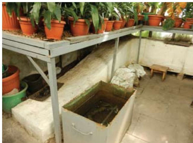
Fot. 2. Kanał pod szklarniowym parapetem
