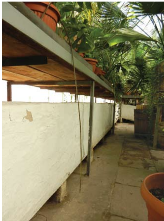
Fot. 3. Kanał pod szklarniowym parapetem
